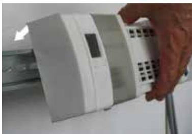
1. Coloque los módulos con los ganchos superiores en el raíl DIN.
