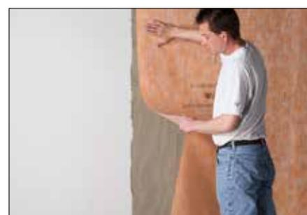
Schlüter-DITRA 25 es una lámina de polietileno con estructura cuadrículada, conformada en forma de cola de milano, con una tela sin tejer en su reverso. En combinación con recubrimientos cerámicos, DITRA 25 sirve de impermeabilización, de capa de compensación de la presión de vapor cuando hay humedad bajo la misma y de capa de desolidarización.
