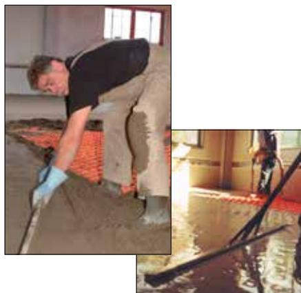
Antes de la realización del recredido se debe comprobar con una prueba de presión la estanqueidad del sistema de calefacción. No se debe realizar calentamiento alguno del recredido, ni durante la ejecución, ni durante el fraguado.
