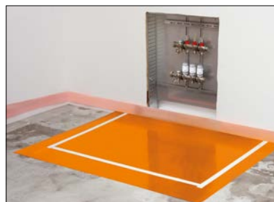
5 Verteilerbereich – beigefügte Doppelklebebänder aufbringen.
