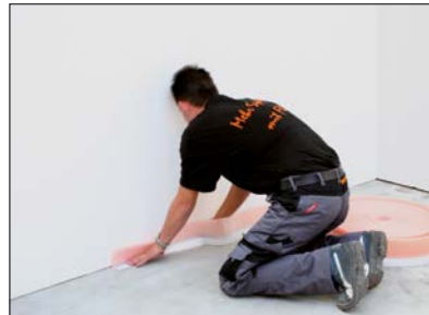
2 Einbau des Randstreifens BRS 808 KSF mit Klebestützfuß.
