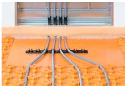
La placa lisa Schlüter-BEKOTEC-ENFGI con aislamiento térmico y aislamiento acústico a ruido de impacto se instala delante de los colectores de calefacción para facilitar el montaje de los tubos de calefacción en el armario de distribución.
