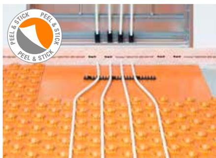
La placa lisa Schlüter-BEKOTEC-ENFGK-PS se instala delante de los colectores de calefacción para facilitar las conexiones y minimizar los cortes. La placa es autoadhesiva por la parte posterior y dispone de un film de protección.
