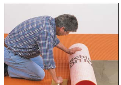
9 Verlegung der Entkopplungsmatte Schlüter-DITRA (in Verbindung mit Keramik- und Natursteinbelägen) in frischem Dünnbettmörtel nach Begehbarkeit des Estrichs. Bei Calciumsulfatestrich nach einer Restfeuchte von \leq 2\% .
