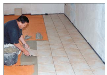
12 Verlegung des Fliesenbelags auf DITRA in Dünnbettmörtel.
